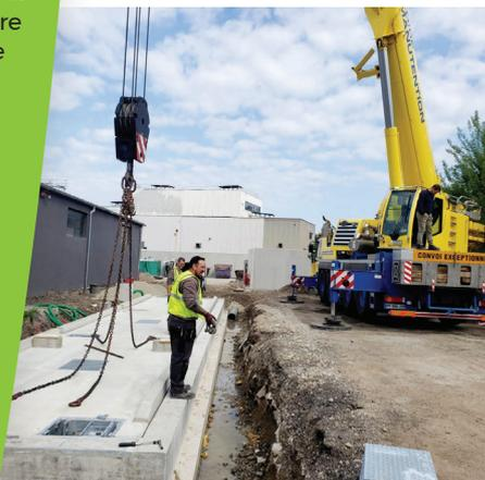
Le pont bascule pendant sa dépose et en exploitation avec son système qui identifie automatiquement le client, la matière transportée et son poids.
